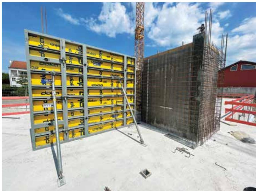
*S tri nova panela visine 3 metra oplate Framax Xlife plus, zidovi u stanogradnji mogu se još ekonomičnije oplaćivati.*
