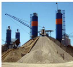
Na betonarama se cement smješta u posebne silose pri čemu se razlikuje vrste i klase cementa ne smiju miješati u istom silosu.
