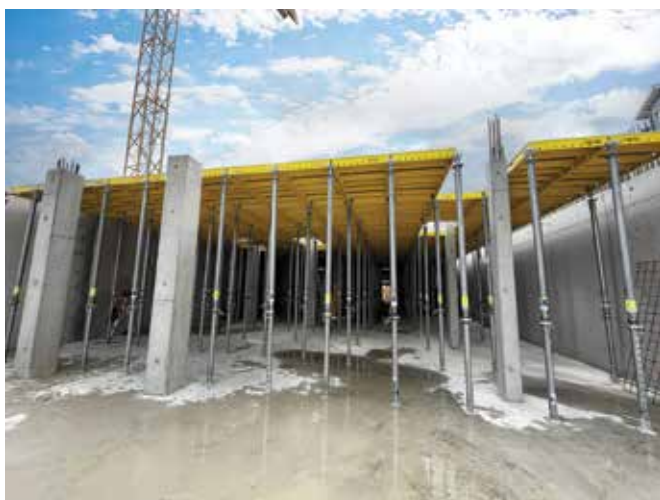
Mogućnošću rukovanja sustavom od strane svega dva radnika, osigurano je tvrtki MAUSS Bau učinkovito izvođenje radova na četverokatnici u Treuchtlingenu, dok je Xlife opladna ploča visoke kvalitete osigurala ujednačenu i glatku površinu betona. Copyright: Doka
