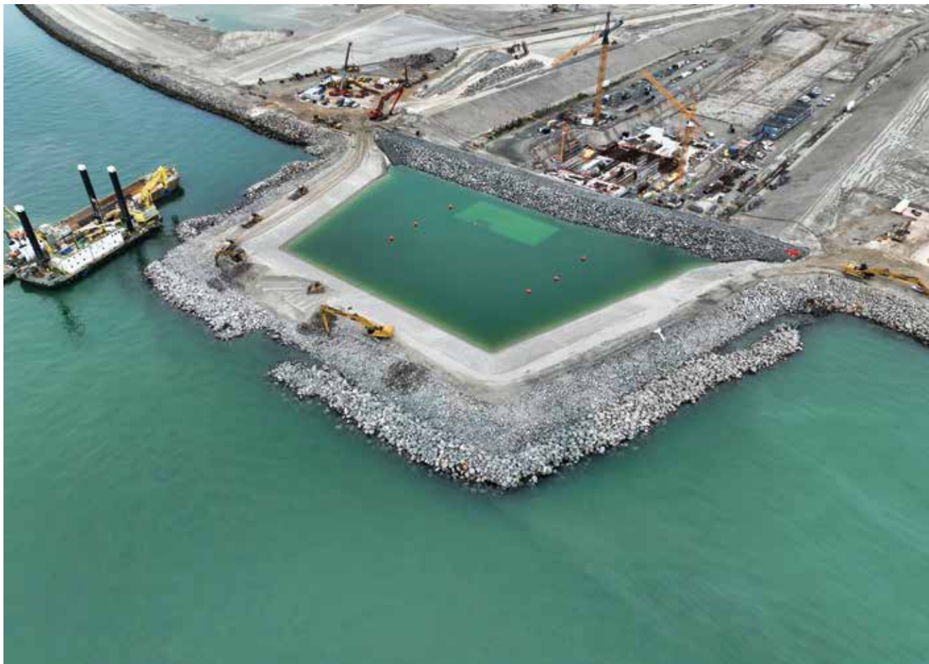
Slika 19. Gradilište portala tunela na danskoj strani, snimljeno u travnju 2024.
