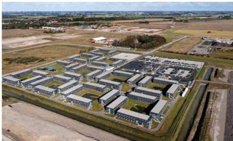
Slika 11. Pogled na stambeni kompleks za radnike na gradilištu
