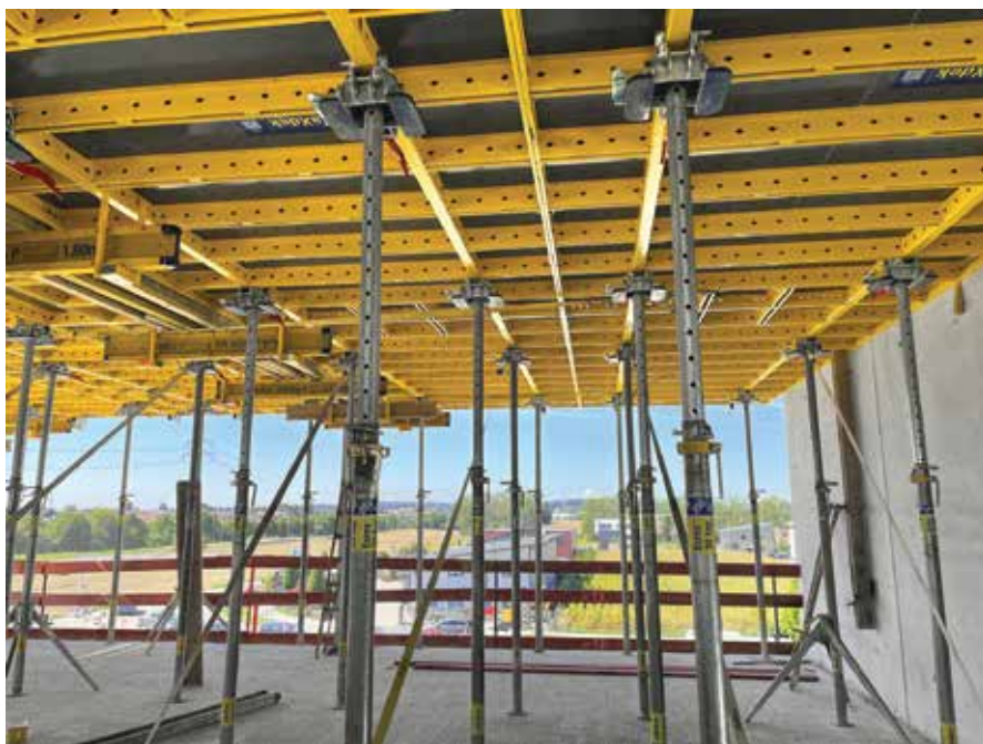
DokaXdek stolovi korišteni su pri izgradnji nove četverokatnice poslovne namjene u Augsburgu u Njemačkoj Copyright: Doka
