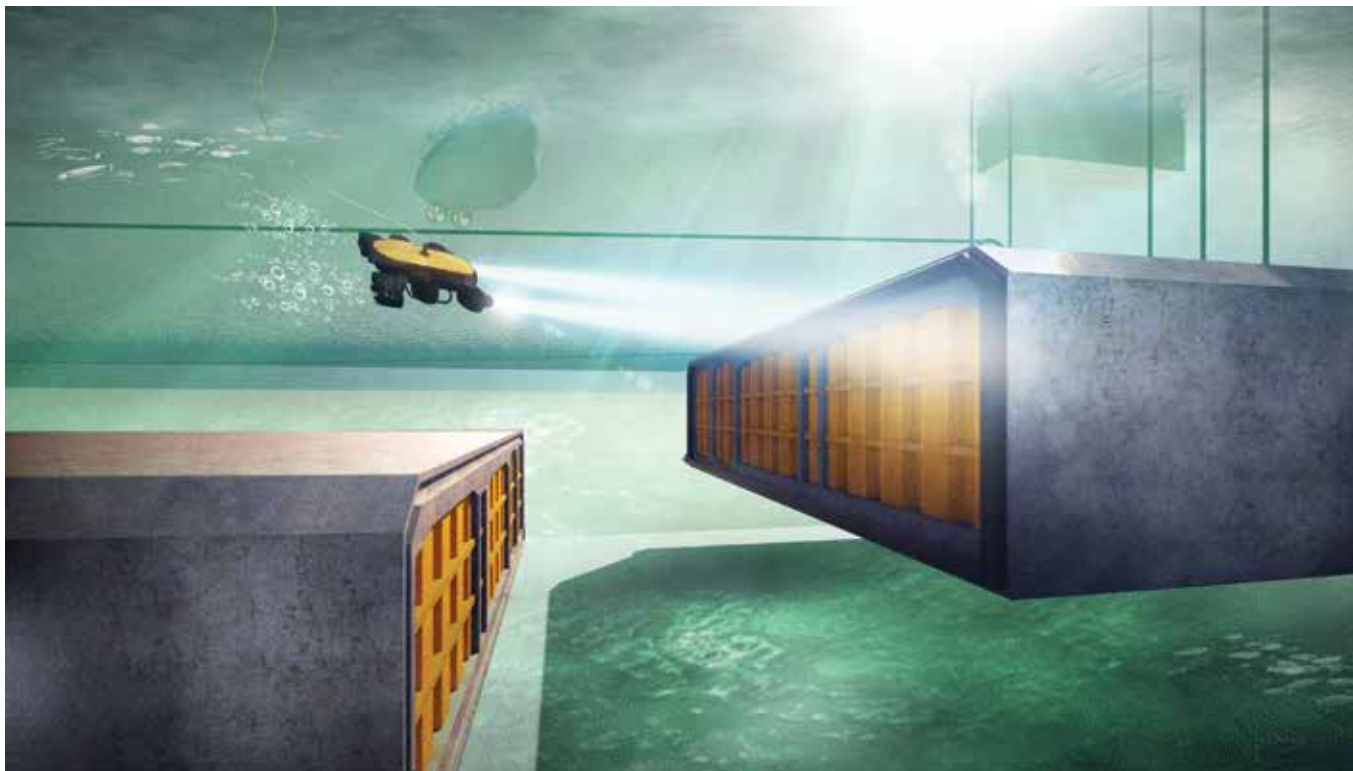
Slika 20. Vizualizacija spajanja tunelskih elemenata u moru
