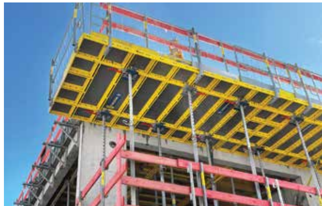
Na projektu Heidepark u Münchenu, DokaXdek stolovi korišteni su i za podupiranje prefabricirnih odnosno montažnih balkona. Copyright: Doka
