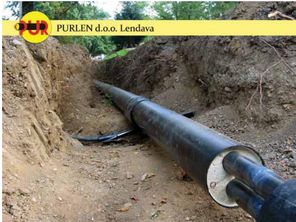
**Dvocevni sistem predizoliranih cijevi**
