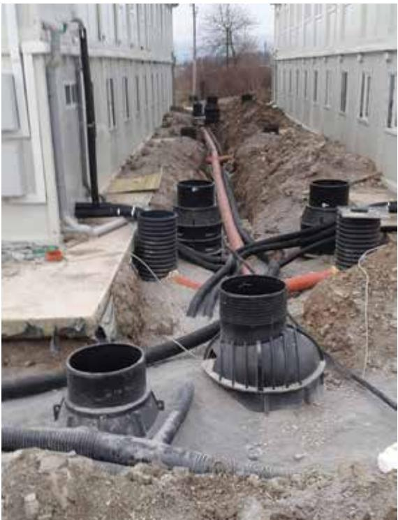
**Fleksibilne predizolirane cijevi za grijanje i toplu sanitarnu vodu**
