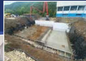
Sistem integralne hidroizolacije postaje gotovo nezamjenjiv prilikom projektovanja i izvođenja radova na hidrotehničkim objektima svih kategorija, kod kojih se prilikom projektovanja armirano-betonskih presjeka kao maksimalni uslov postavlja prevencija pojave naknadnih prslina i pukotina u betonu. Penetron sistem uspješno rješava navedeni problem, tako što prsline širine do 0,5 mm u kontaktu sa vodom imaju efekat samozalječenja i trajne zaštite betona.
