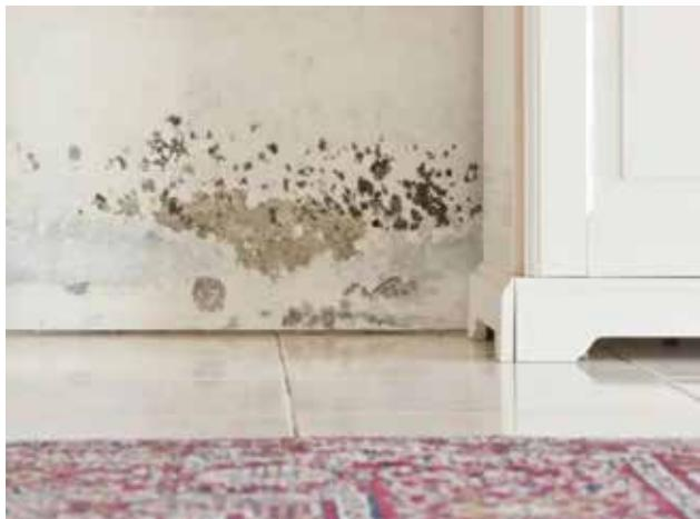
Ovdje govorimo o nepreciznosti izvedbe toplinskih fasada, gdje se između pojedinih slojeva unutar građevnog sklopa, dešavaju sitna „curenja“ topline. Fasada je zajedno s krovom, najveća površina preko koje kuća diše, gubi ili dobiva energiju. Tu su zbog nepreciznosti izvedbe mogući skriveni mikro toplinski mostovi, na spoju dviju ploča toplinske izolacije ili na mjestima njihovog pričvršćenja na fasadi.
