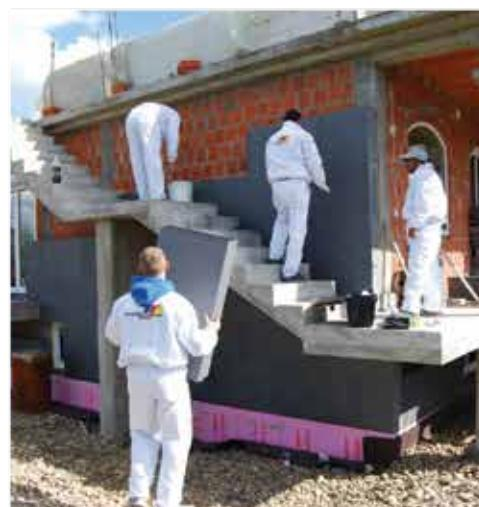
Recimo i to da su fasadni zidovi objekata tzv. **niske energetske potrošnje** ili objekata koji spadaju u kategoriju **pasivnih kuća** po pravilu izolovani „sivim“ EPS-pločama.
