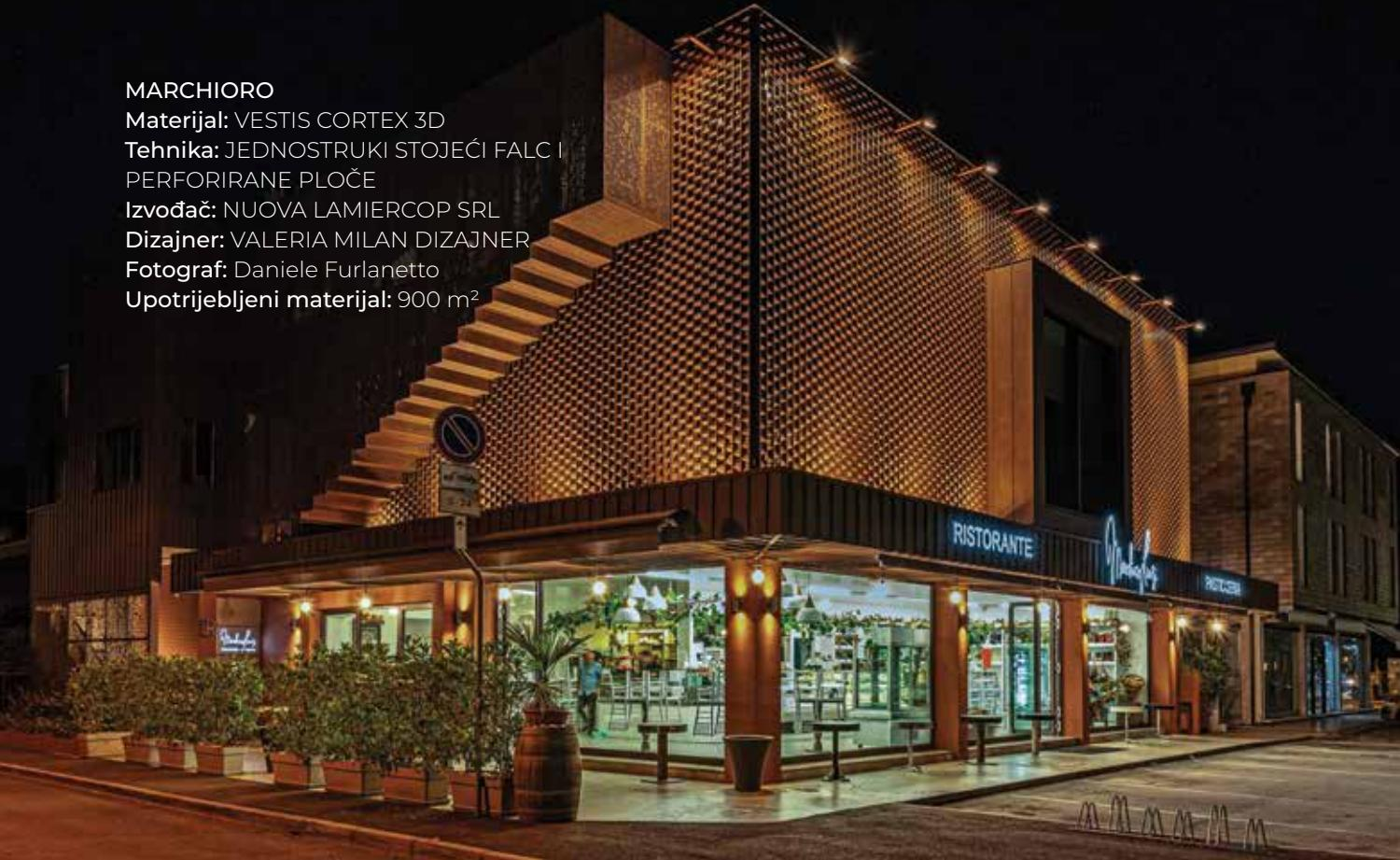
oblike arhitektonskih volumena potpornih struktura i krovova; ova tehnika se nadopunjuje perforiranim metalnim materijalom veće debljine koji oblikuje volumen vanjskog stepeništa i igrom prozirnosti dodaje rafiniranu notu cijelom objektu.
