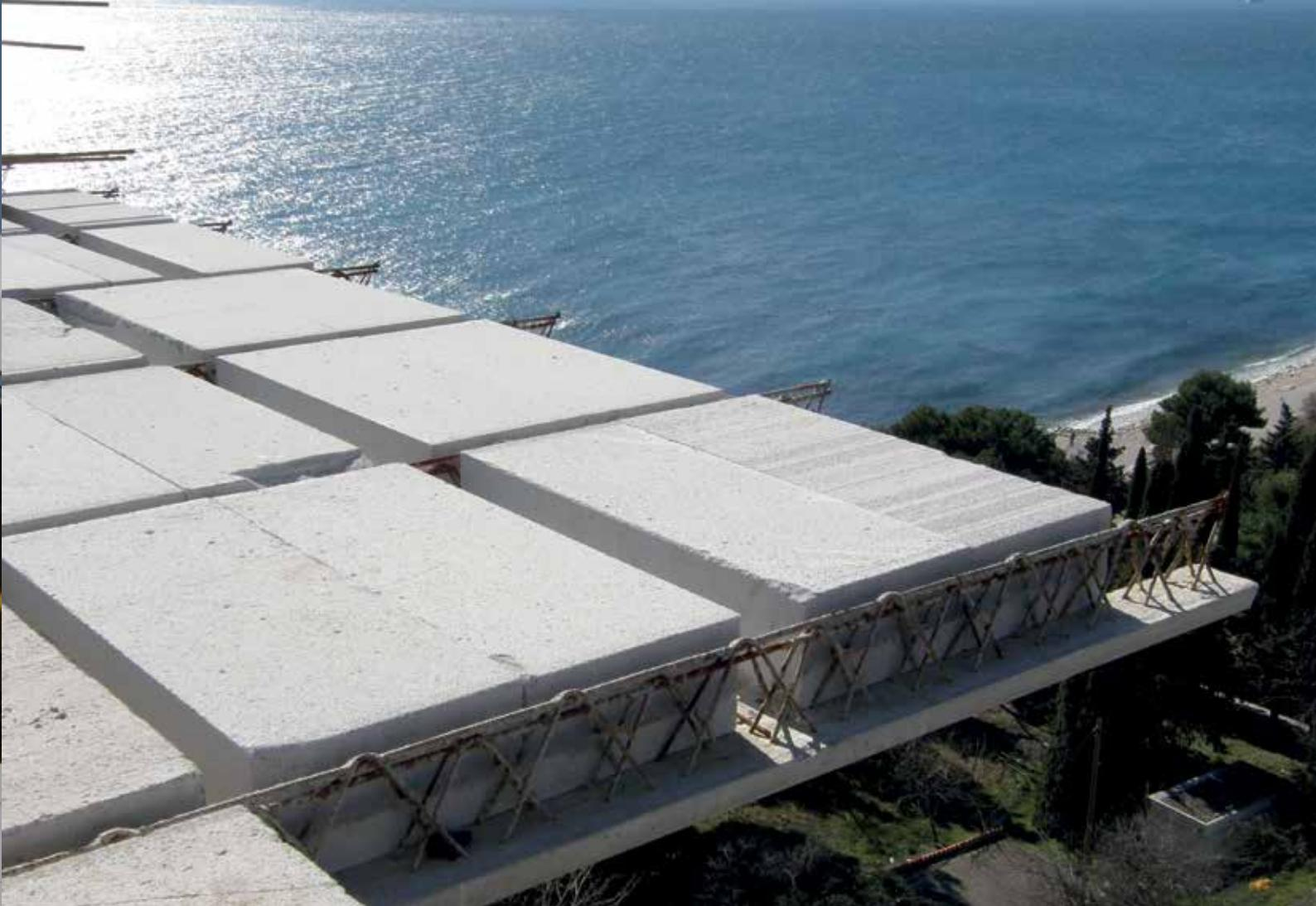
požara Ytong strop je toplinski stabilan sistem koji učinkovito ublažava temperaturne oscilacije vanjskog zraka. Pomaže osigurati toplu unutarnju klimu zimi i ugodnu hladnu klimu ljeti. Pravilno izveden Ytong strop osigurava važećim propisima zahtijevanu zrakotjesnost objekta i time zadовољava ključne kriterije niskoenergetske ili pasivne gradnje. **Ytong strop je također vatrootporan sistem (REI 90), u slučaju požara u dimnjaku, vatra se neće proširiti na donje prostorije.**
