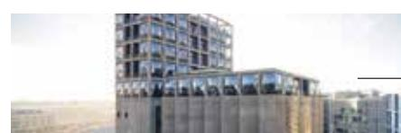
138. Silos je visoka građevina, najčešće izvedena od čelika, armiranog ili prednapregnutog betona, namijenjena pohrani rastresitih tvari kao što su žito ili cement.
